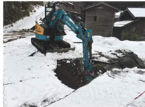
被災地の復旧工事
